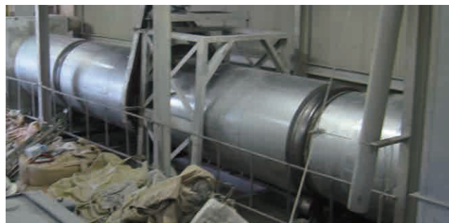
ロータリーキルン保温工事
