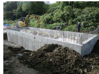
ピット内のFRP槽
