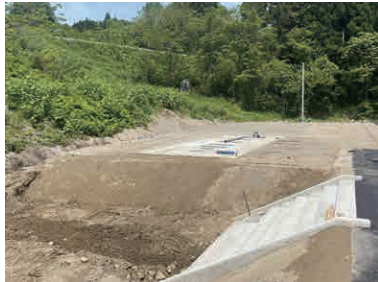
浄化槽の天端の高さ
