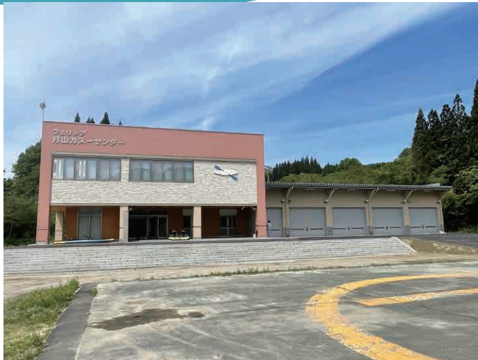
新設した「フェリシア月山カーナーセンター」
