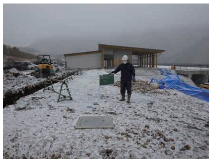
施工中の土壌浸潤槽
