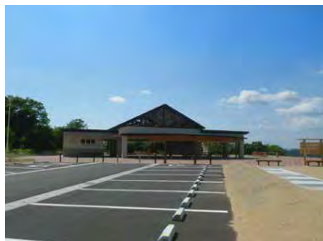
建屋(奥)、原水ポンプ槽・一次処理槽(右)
