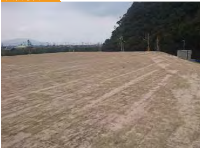
芝生広場と土壤浸潤槽
