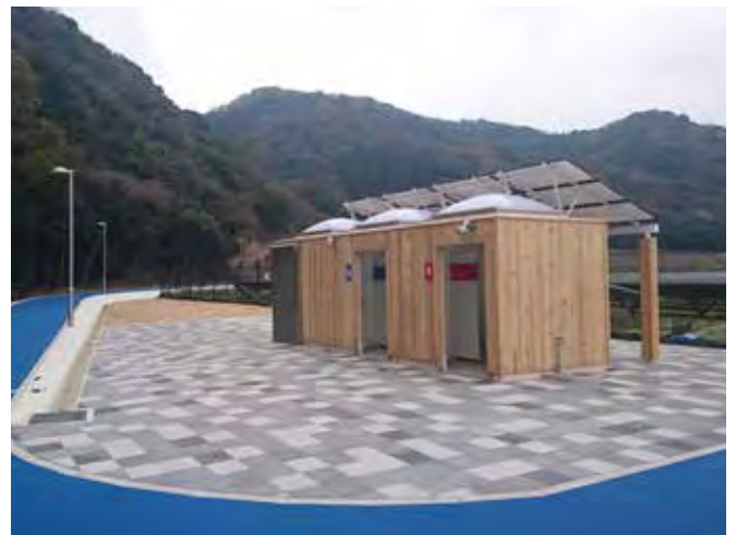
トイレ建屋、太陽光発電・蓄電設備
