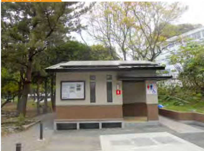
トイレ建屋と一次処理槽（手前）、土壌浸潤槽（右）
