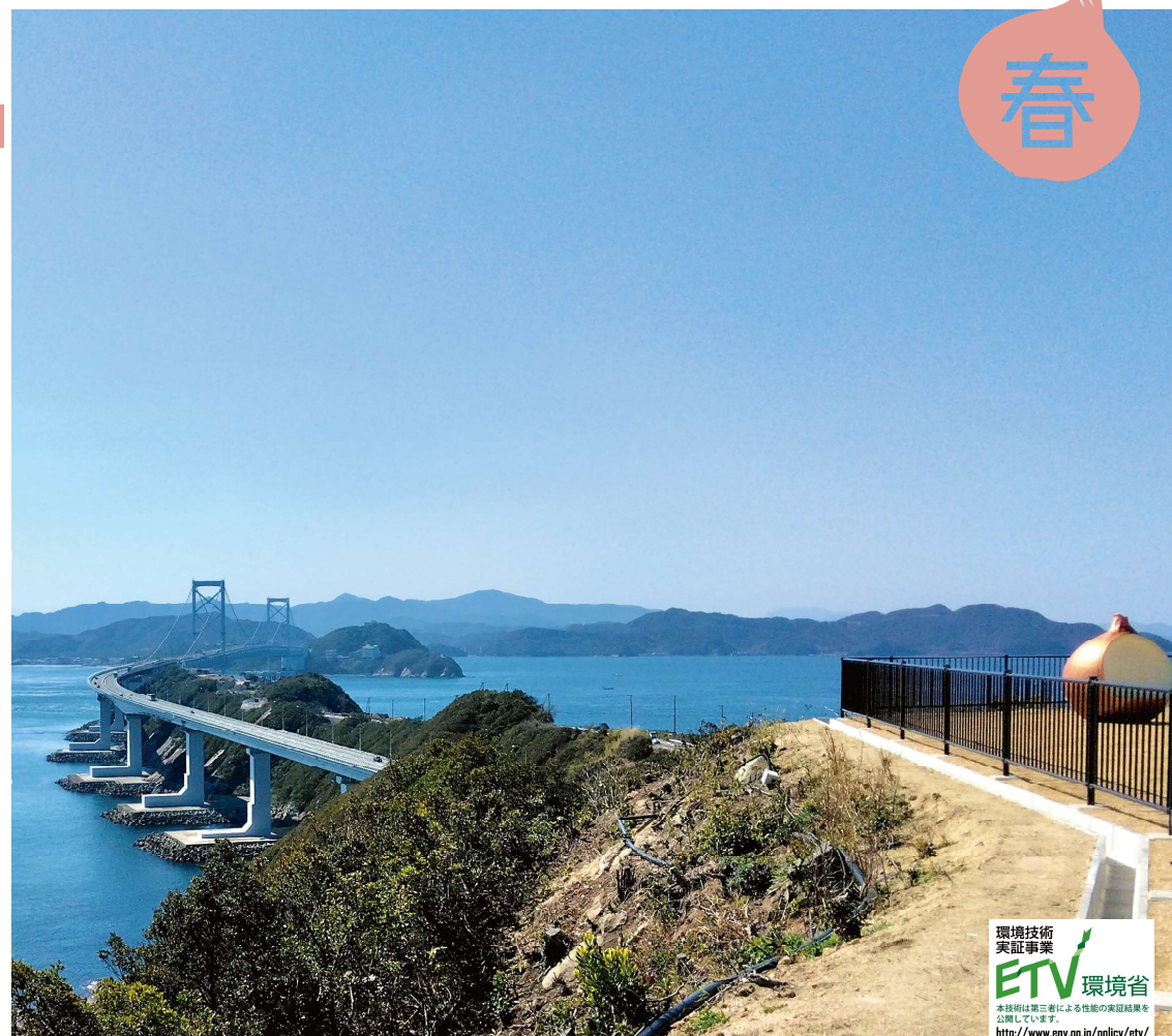
兵庫県南あわじ市「鳴門岬駐車場うずまちテラス」
