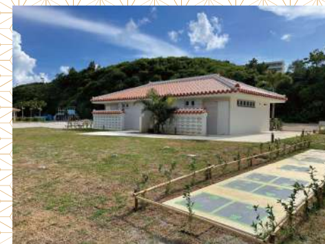
トイレ・シャワー棟、装置全景(北便所側)
