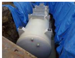
一次処理槽 施工中
