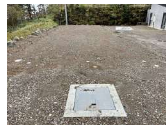
土壌浸潤槽 完成
