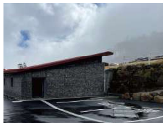
一次処理槽 完成
