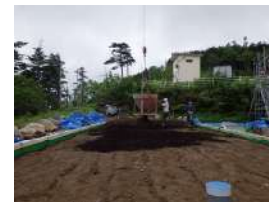
土壌浸潤槽 施工中
