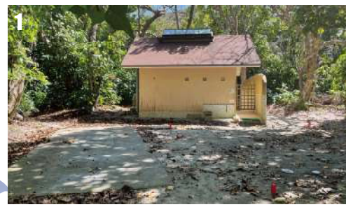
1 トイレ建屋 2 周辺風景 施工時期：2015年3月 システム：ソフィール循環 人 槽：20人槽 汚水量：3.0m3/日 発注者：東京都 小笠原支庁
