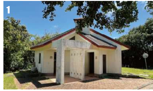
1 トイレ建屋 2 周辺風景 施工時期：2010年3月 システム：ソフィール循環 人 槽：112人槽 汚水量：1.0m3/日 発注者：東京都 小笠原支庁
