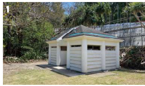
1 トイレ建屋 2 周辺風景 施工時期：2013年3月 システム：ソフィール循環 人 槽：20人槽 汚水量：3.0m3/日 発注者：東京都 小笠原支庁
