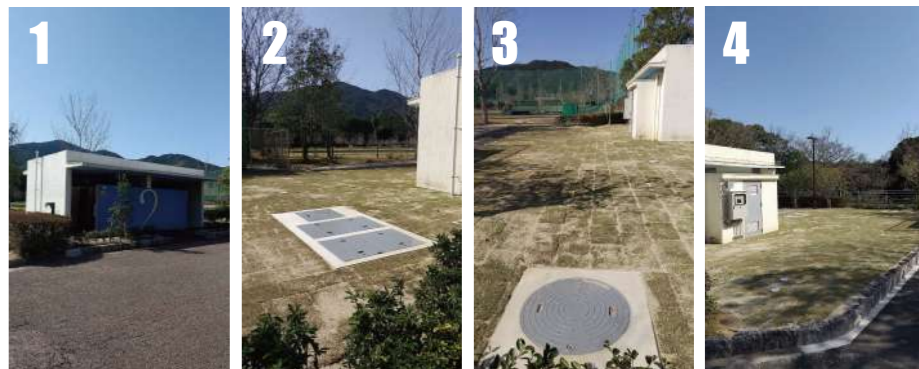
<中央広場 南(Na2)> 1 トイレ棟 2 一次処理槽 3 消毒槽 4 土壌浸潤槽
