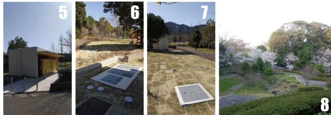
<芝生広場 北西(Na3)> 5 トイレ棟 6 一次処理槽、消毒槽 7 分水マス、土壌浸潤槽 8 周辺風景
