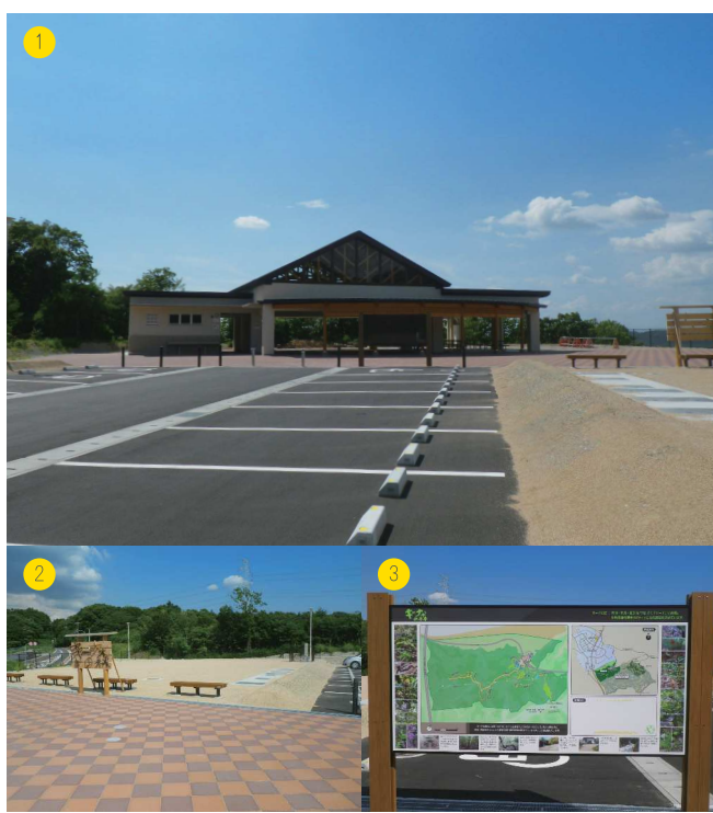
1 トイレ建屋 2 処理装置 3 案内板
