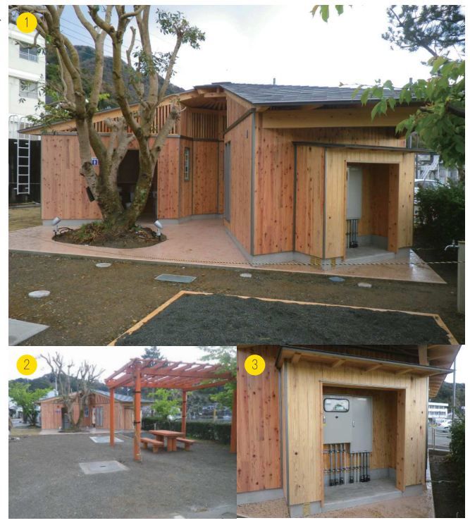
1 トイレ建屋 2 公園全景、処理装置 3 制御盤
