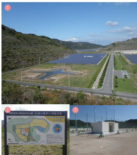
① 周辺風景 ② 案内板 ③ トイレ建屋、浄化装置
