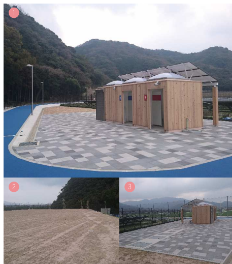
① トイレ建屋、太陽光発電設備 ② 土壌浸潤槽 ③ トイレ建屋、一次処理槽
